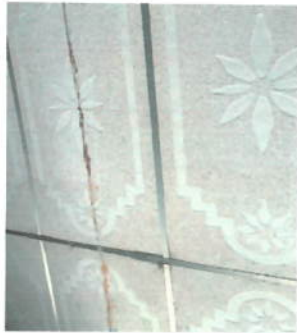
Foto1: Reparación de cielo falso con sus respectivos soportes y accesorios.
