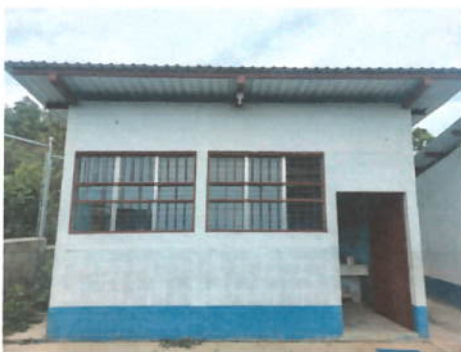
Foto 5: Preparación de la superficie y aplicación de pintura a dos manos, en paredes interiores y exteriores del establecimiento.
